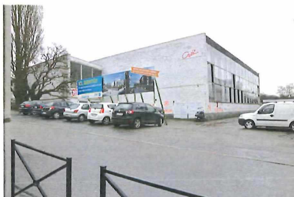
Rue de Verrewinkel 95, ancien pavillon du Tabac à l'Expo '58, 2015
